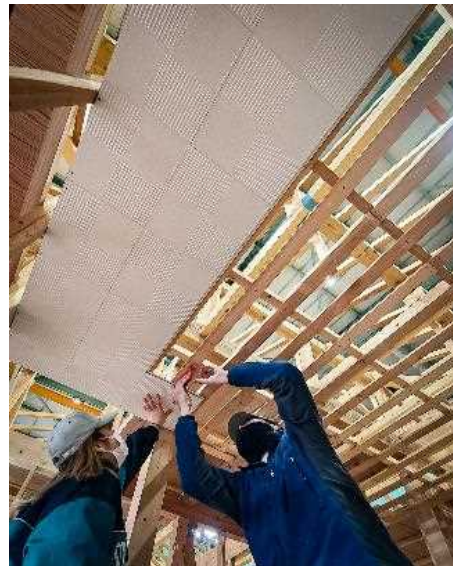
内部造作作業（天井）
