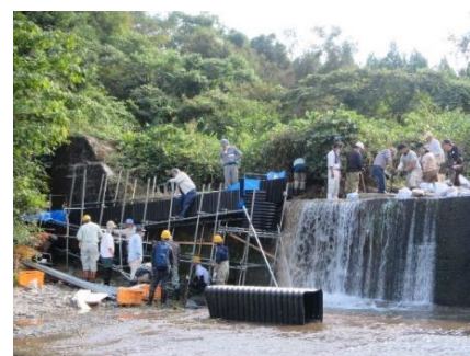
写真3-1. 仮設魚道の設置
