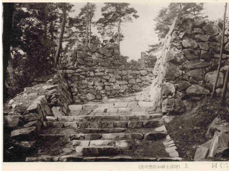
図 3 戦前調査時の天主台 穴蔵入口の状況 （『滋賀縣史蹟調査 報告 第十一冊 安 土城址』より転載） 上：調査前 下：保存工事後
