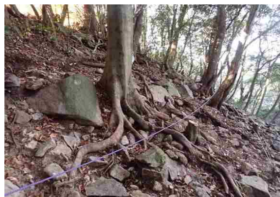
天主台東面石垣築石残存状況（南東から）
