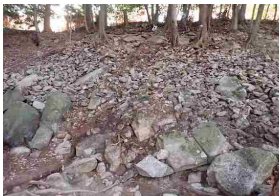
天主台東面の崩落状況（東から）
