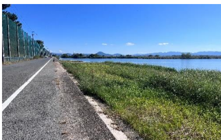
木浜内湖底質改善対策 (覆土工) (守山市木浜町他)
