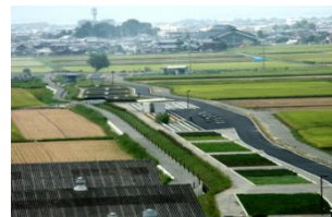
山寺川市街地排水浄化施設「伯母川ピオ・パーク」
