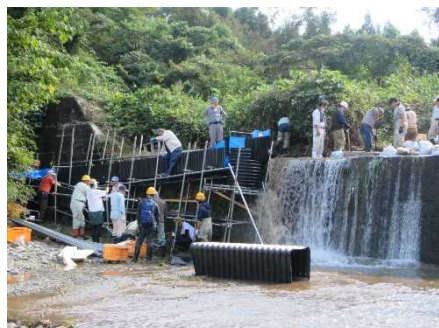
図5 設置したピワマス魚道 (上：家棟川、下：渋川)
