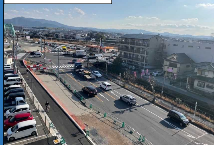
工事中(2024年1月撮影)
