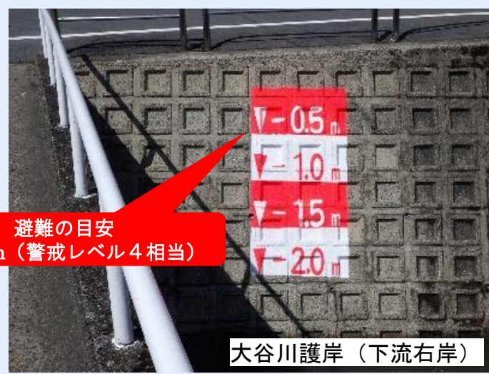
大谷川護岸 (上流右岸)
