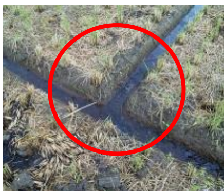
つなぎ目はしっかりつなぐ！ 弾丸暗きょは明きょとつなぐ！ 心土破碎で排水性向上！
