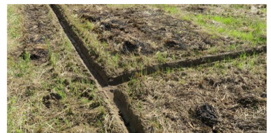
溝のつなぎ目の部分は必ず連結する
