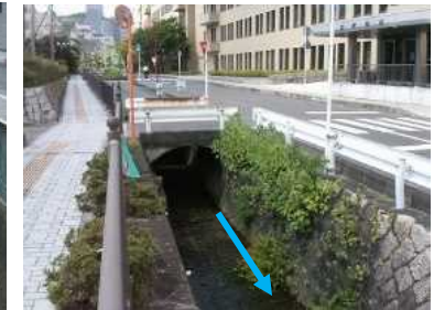
滋賀県庁前より上流を望む (吾妻川)
