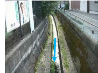
無名橋より上流を望む (常世川)
