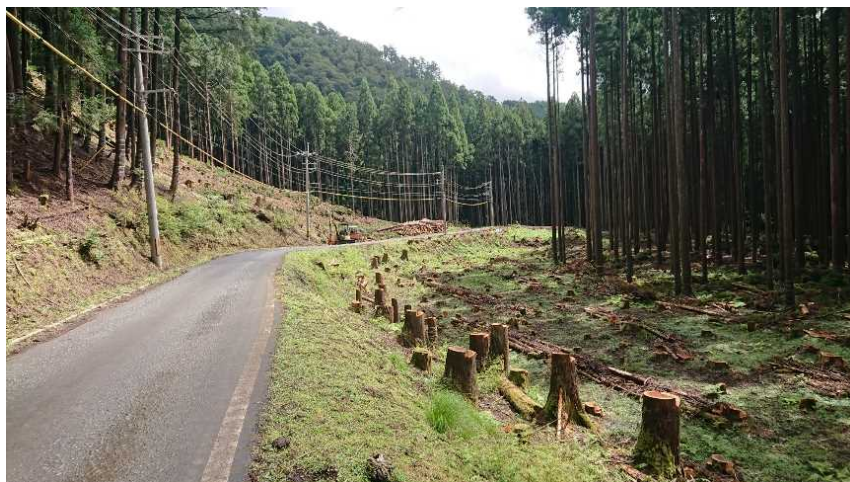
道路沿いの予防伐採を行った現場
