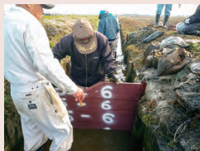
◀魚が田んぼにのぼりやすくするためにせき板を設置しているよ。
