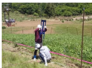
支柱の打ち込み
