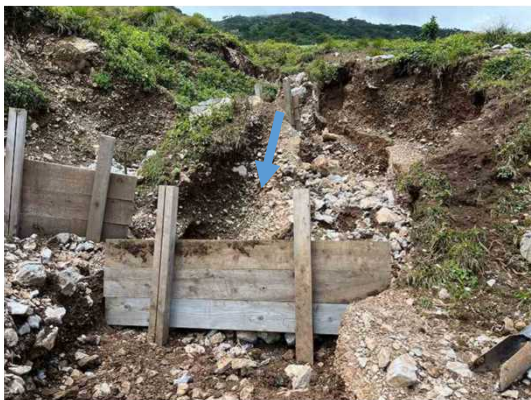
2.排水対策（土留め）
