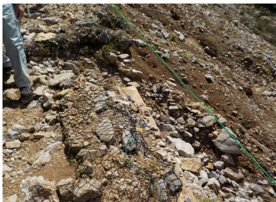
4.登山道修繕（袋詰めネット）
