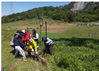
樹脂ネットの撤去
