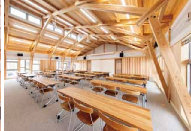
〈大会議室〉6間スパンを支える多角形アーチ構造 横架材は長浜、米原、高島など県北部の杉材
