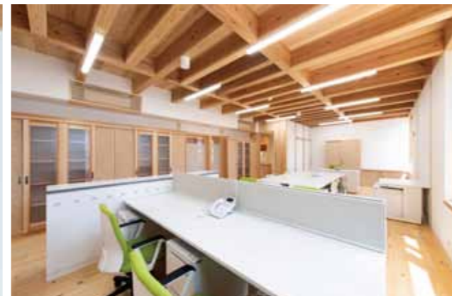
〈1F 事務室〉4m材・レシプロカル構造 3間スパンを支える2F床組架構 住宅用4m材使用、天井は張らず2階床組み現し
