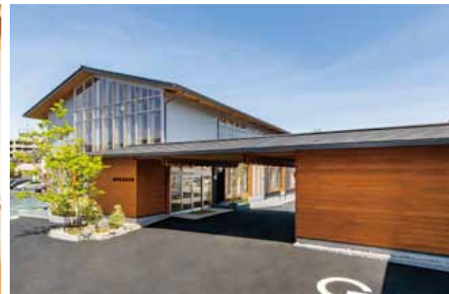
〈ピロティ〉6m材・レシプロカル構造 北部の杉材使用 4間スパンを支える屋根架構、大径木利用の提案として6m材を組合せて鉄骨造に匹敵するスパンを実現
