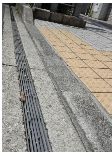
画像8 車道との段差に配慮した歩道
