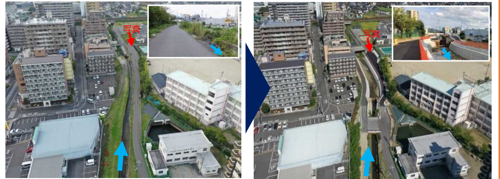
■野洲川(流下能力確保のため、河道掘削を実施)
