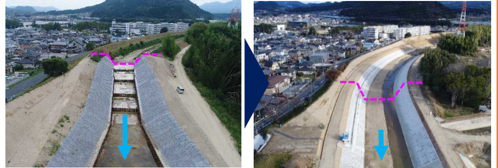
■北川(天井川の切下げ改修を実施)
