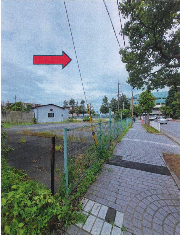
⑨ 敷地内にある敷地外電柱の地支線
