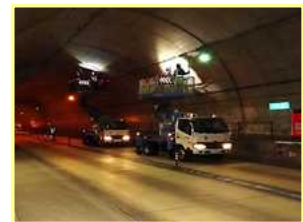
点検状況 【国道 421 号 (石樽トンネル)】
