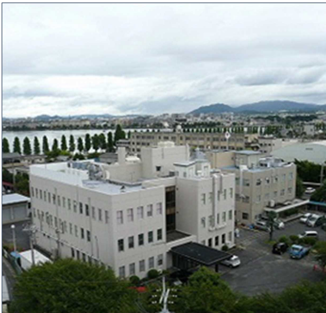
新館(写真左側):昭和50年(1975年)築 旧館(写真右側):昭和45年(1970年)築
