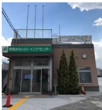
管理棟・艇庫入り口を撮影
