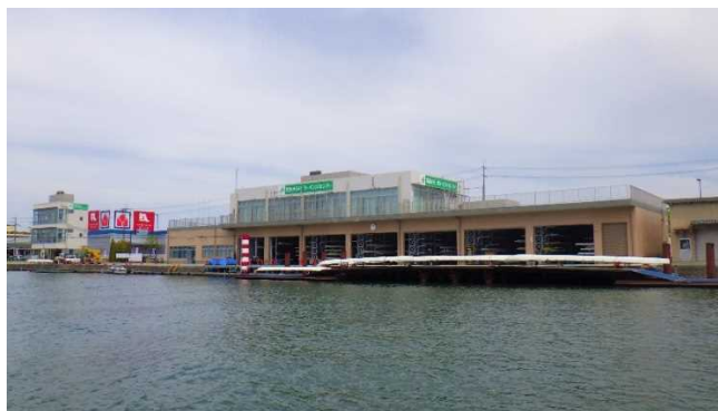
管理棟・艇庫を琵琶湖から撮影
