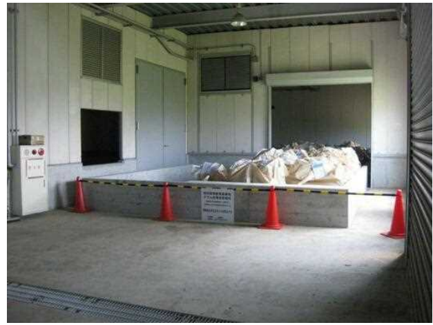
室内仮置廃棄物保管対策工 対策後
