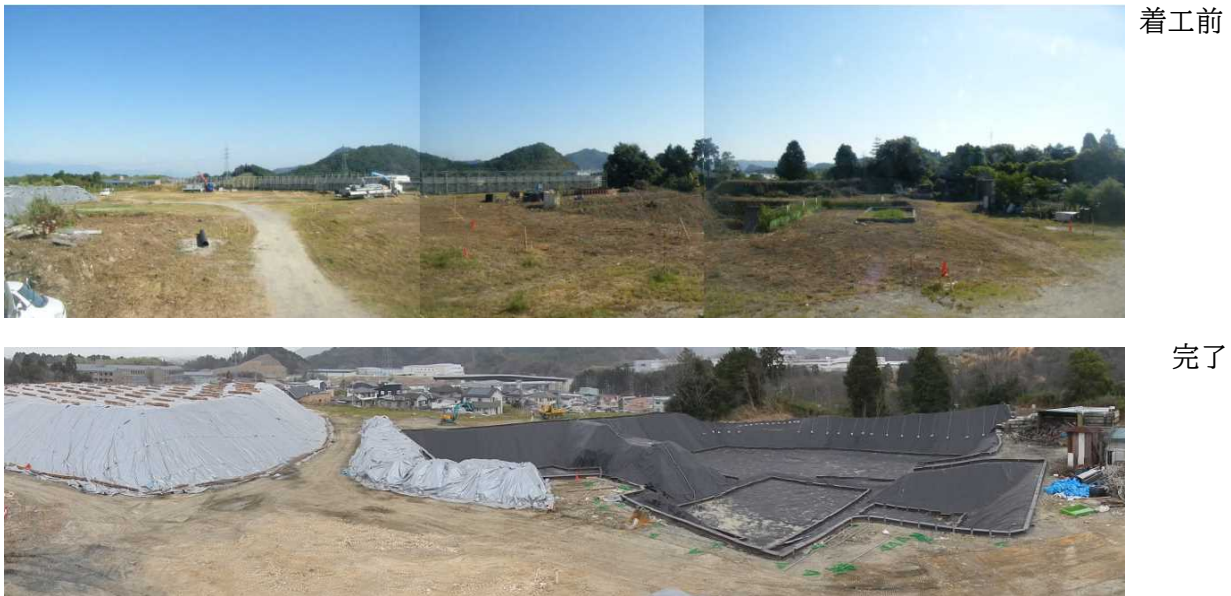
図 3-2-1 有害物等の掘削除去の状況
