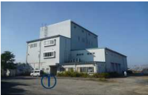
① ガス化溶融炉建屋
