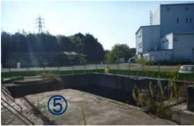
⑤ 南側焼却炉基礎
