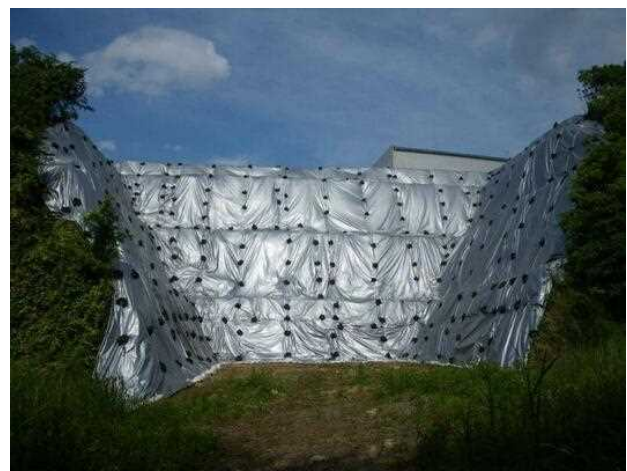
仮設シート（西市道側法面部）張り替え後
