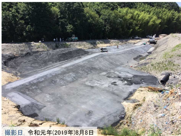
図 4-2-5 底面遮水および側面遮水の施工状況
