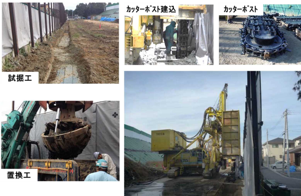
図 4-2-4 鉛直遮水壁の施工状況
