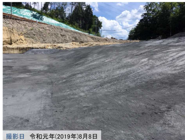
図 4-2-5 底面遮水および側面遮水の施工状況
