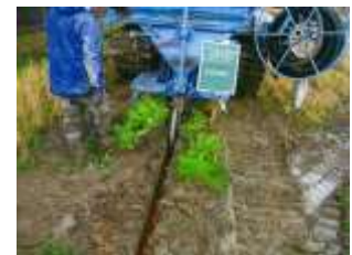
暗渠排水の施工状況
