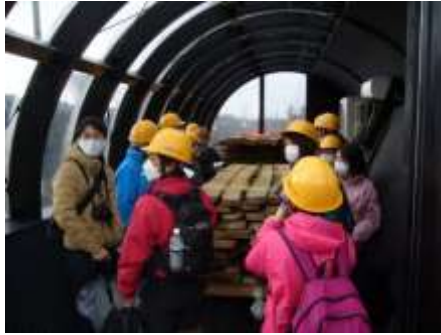
太陽熱利用木材乾燥庫
