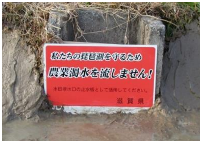
農業濁水の流出を止める止水板
