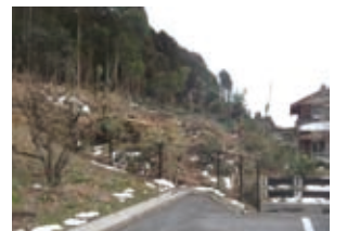
▲施工後防災機能の強化された里山
