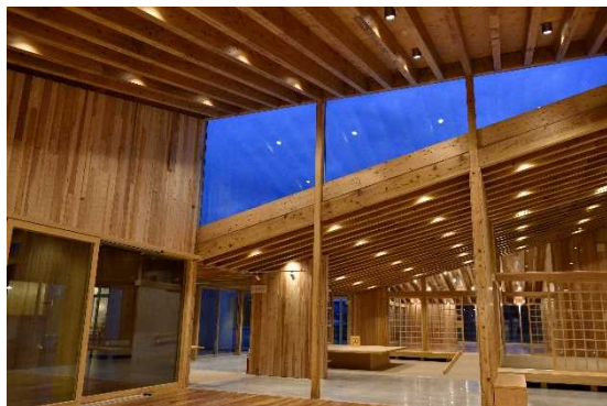
図 8 木造公共施設
