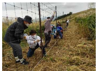
9月16日金属柵設置作業
