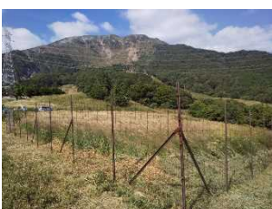
9月16日金属柵設置完了
