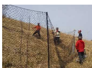
カタクリ群生地のネット設置
