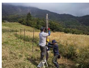
9月15日金属柵支柱設置
