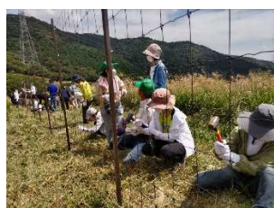
9月16日金属柵設置作業
