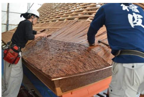
〔檜皮葺の施工の様子〕
