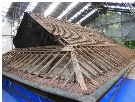
解体中の状況
