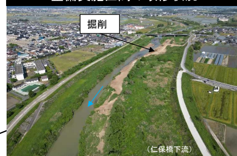
整備実施区間の改修状況
