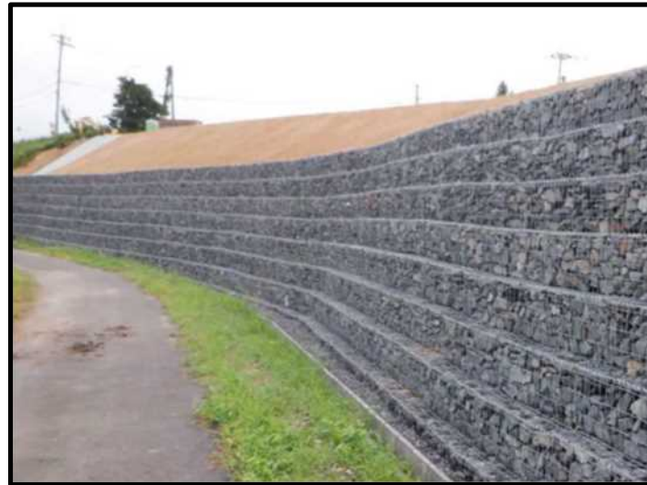
光善寺川の堤防補強工(ドレーン工)
