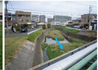
下鉤橋より上流を望む (中ノ井川)
