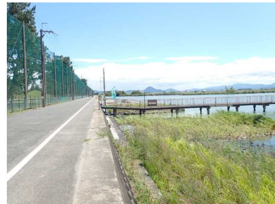
覆土への湿性植物の植栽
