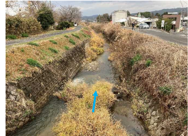
県道4号より下流を望む
