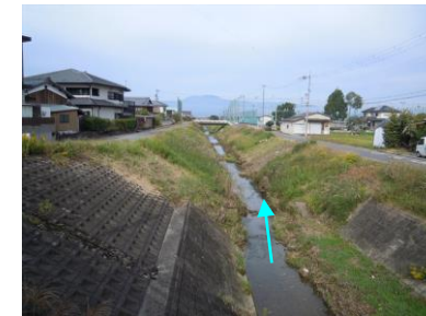
② 川ノ下橋下流
