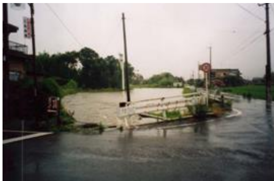
守山川・金森町 (平成11年6月26日洪水)
