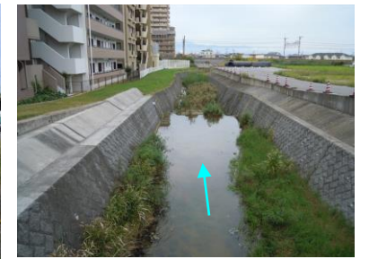
① 下北池1号橋下流
