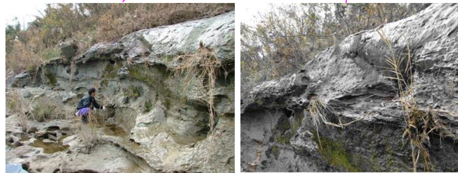
野洲川の古琵琶湖層（甲西中央橋上流 左岸）
