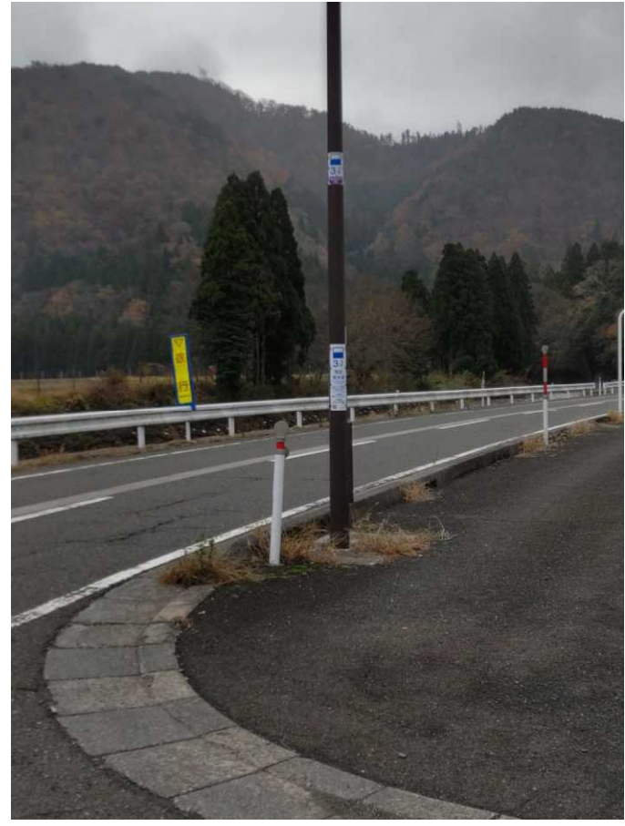
まるまち看板の設置状況 (長浜市余呉町下丹生)
