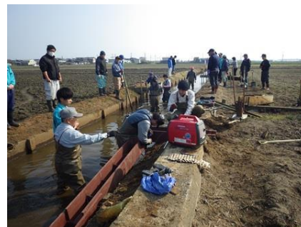
魚道の設置作業
