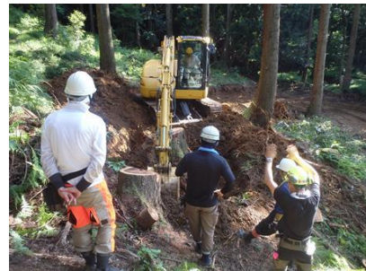
作業道作設オペレーター研修
