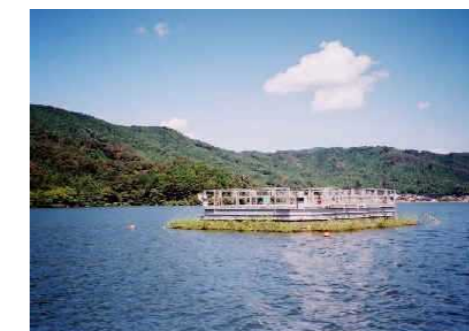
深層曝気装置の設置(余呉湖)
