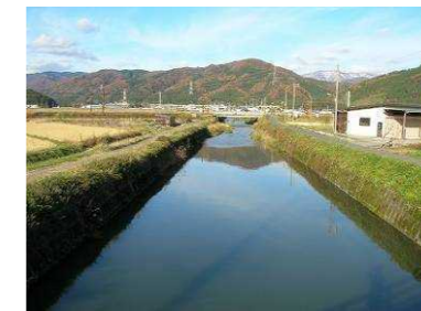
余呉川導水路
