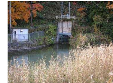
放水路トンネル
