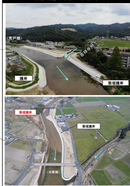
整備実施区間の改修状況
