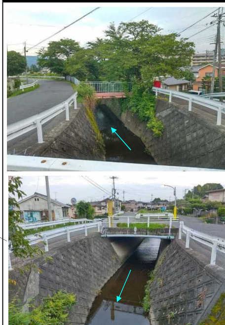
整備実施区間の状況
