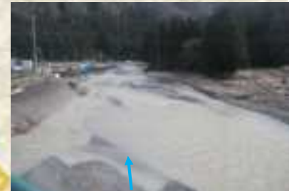
④中川原橋下流 3/20 15:45 濃い濁り (濁度88mg/l)
