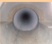
【湖東幹線(東近江市)のマンホール内部】
