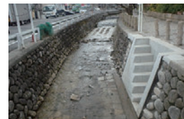
階段の設置（相模川：大津市）
