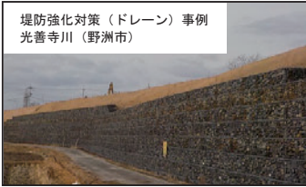
堤防強化対策（ドレーン）イメージ図
