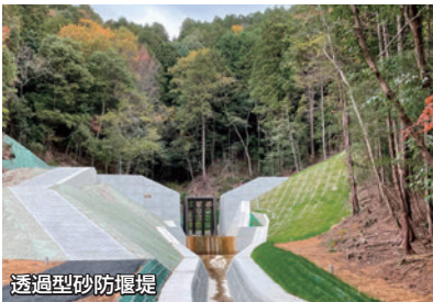
透過型砂防堰堤
