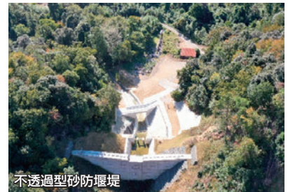
不透過型砂防堰堤
