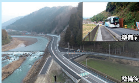
川合千田線（長浜市） 集落を結ぶ山間部の狭い道路の幅員を広げ、安全に通行できる道路を整備しました。
