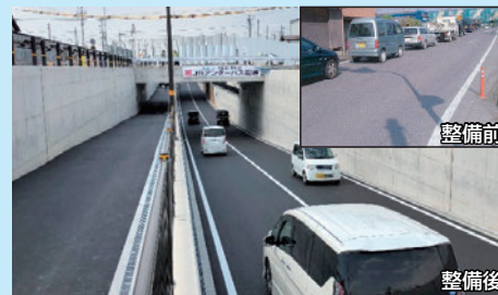
愛知川彦根線（彦根市） 踏切待ちによって渋滞していた道路に対して、立体交差を整備しました。
