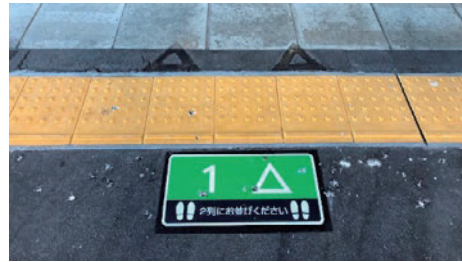
内方線付き点状ブロックの整備（真生川駅）
