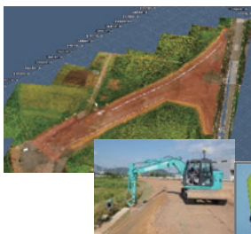
ICTバックホウによる法面整形 (仕上げ形状データを機械に入れて自動操作)
