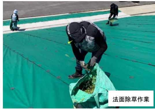
天端除草作業
