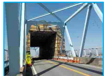
修繕 (塗装塗替) 状況 【米原跨線橋】
