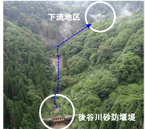
砂防堰堤で土砂及び流木を捕捉
