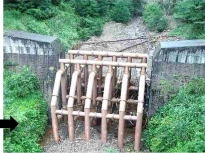
砂防堰堤で土砂及び流木を捕捉
