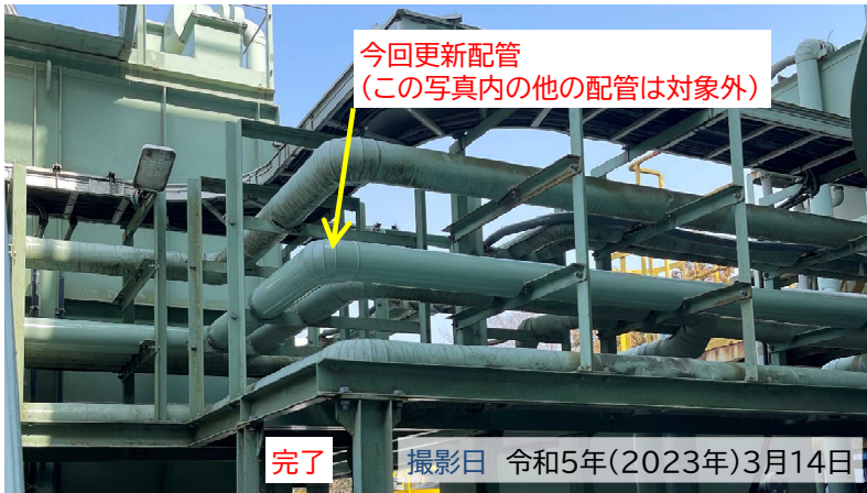
内側に付着物の付いた配管の更新
