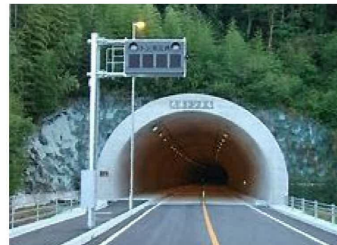
(警報表示板施工イメージ)
