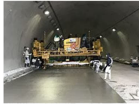
(コンクリート舗装施工イメージ)
