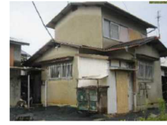
既成市街地や農村集落等において 残存する空き家
