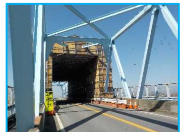
修繕 (塗装塗替) 状況 【米原跨線橋】
