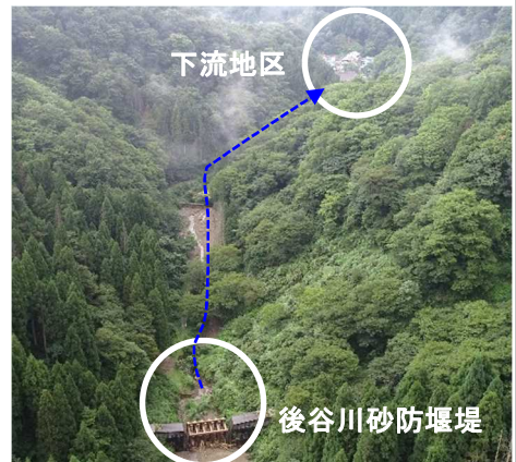
砂防堰堤で土砂及び流木を捕捉
