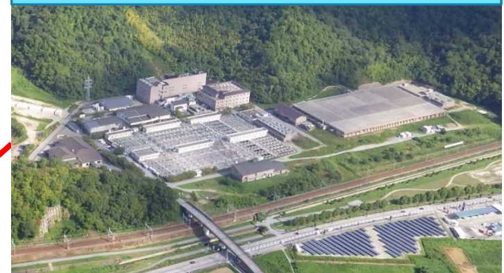
東北部浄化センター(平成3年4月供用)
