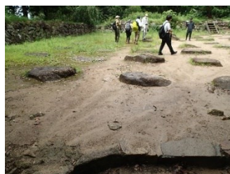
図 7-11 雨水による遺構面流失の状況（天主台穴蔵床面）
