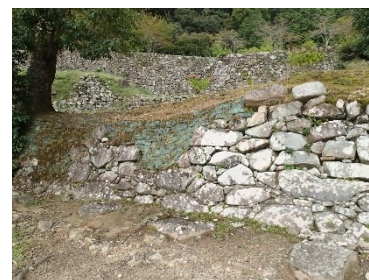
図 7-9 石垣整備事例 土嚢充填による構築時石垣保護 (伝羽柴秀吉邸跡)
