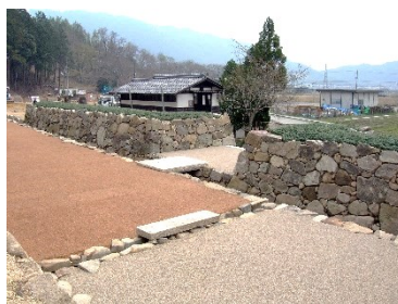
図 7-8 石垣整備事例 新規積みによる整備(大手石塁)
