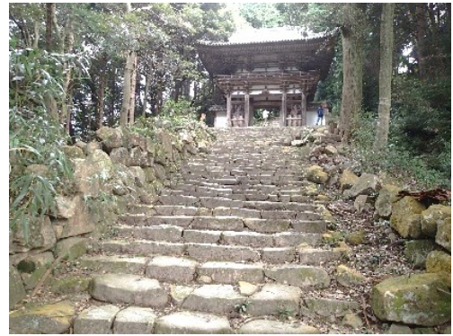
図 8-15 百々橋道現況(二王門下)
