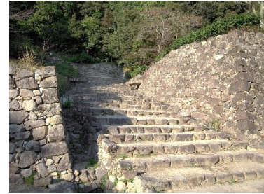
図 7-3 大手道環境整備発掘調査・整備後の状況(埋戻)
