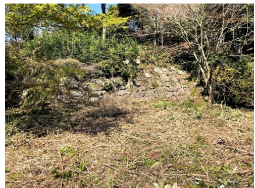
図 8-10 天主台北西面現況 (除草・灌木伐採直後の状況)
