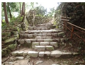
図 7-5 石段の露出公開 (天主台穴蔵入口)
