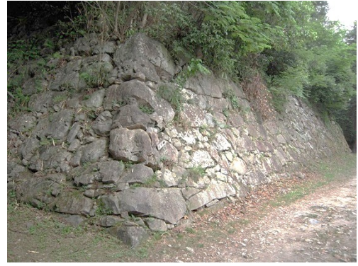
(天主台隅角部)
