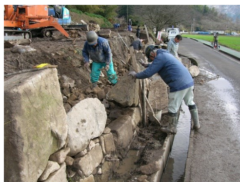
図 3-19 大手口～百々橋口石垣の復元 （平成 19 年）
