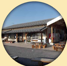
道の駅せせらぎの里こうら
